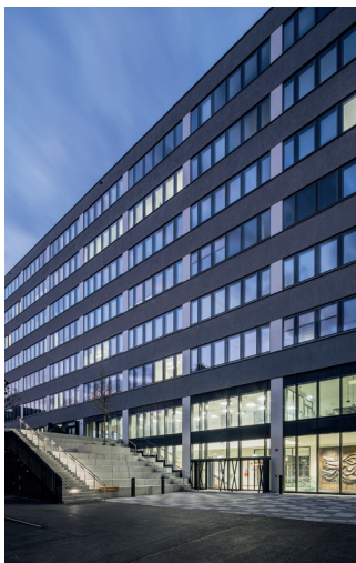
Fritz-Pregl-Straße 3: Das Vorgängergebäude war ein „Energiefresser“, inzwischen ist es ein Vorzeigeprojekt für Energieeffizienz.
